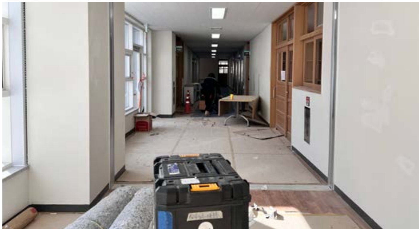
2. 작업 중인 복도를 지나 다목적실로 이동
